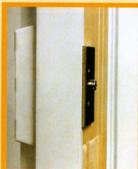
Gâche fait en acier inoxydable boulonnée sur une plaque de sécurité en acier sécurise la gâche au cadre de bois traité.
